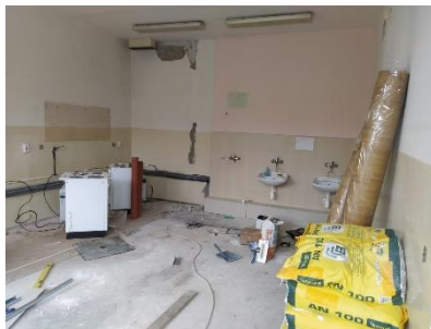
Průběh rekonstrukčních prací
